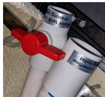
Åbn Servicelåge til afløbshanen og åbn ventilen
